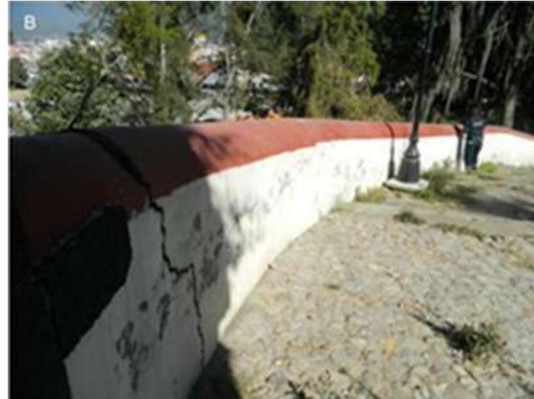
Fotografías. Agrietamiento en la iglesia del Señor del Sacromonte
